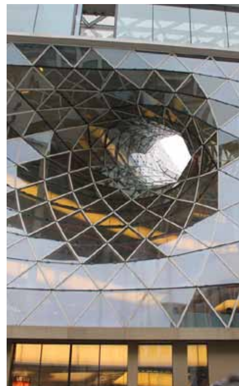
Ein ganz besonderer Hingucker ist das Loch in der Glasfassade
